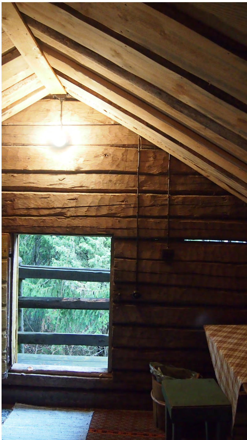
Päädyn huoneeseen johtaa matala ovi. Hirren veistojälki näkyy hyvin.
