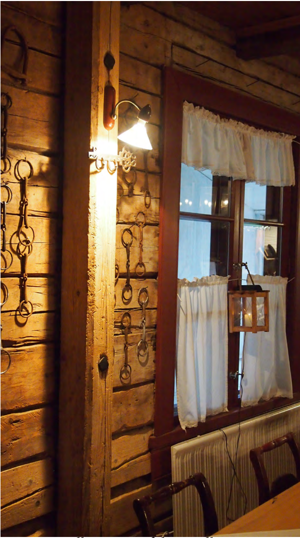
Hirsinavetan ulkoseinä ja följärit, alkuperäinen ikkuna-aukko. Vanhan mukaan tehdyt ikkunat.
