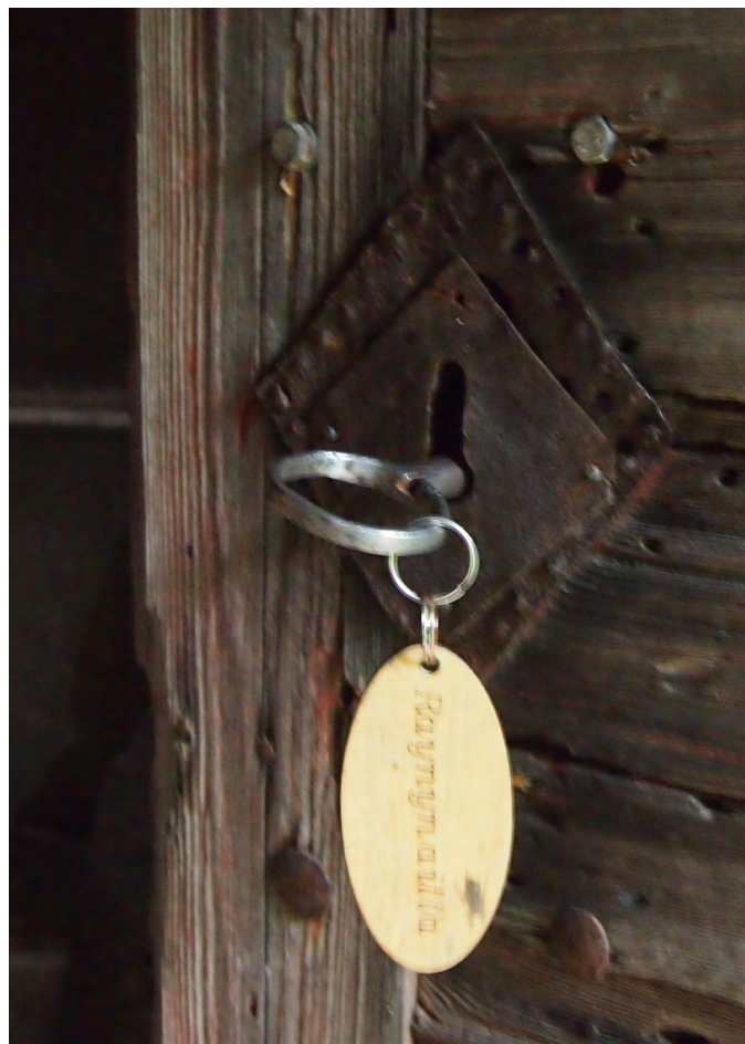
Yksinkertainen tapa tehdä porras: lauta lovetaan reisipuuhun. Kyläseppän tekemä avaimenreikä kehystävä levy.
