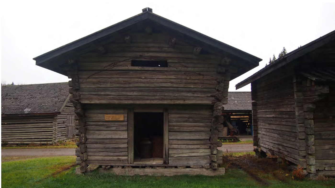
Oven vieressä olevat leveät hirret toimivat samalla karapuina. Ovi aukeaa sisäänpäin.
